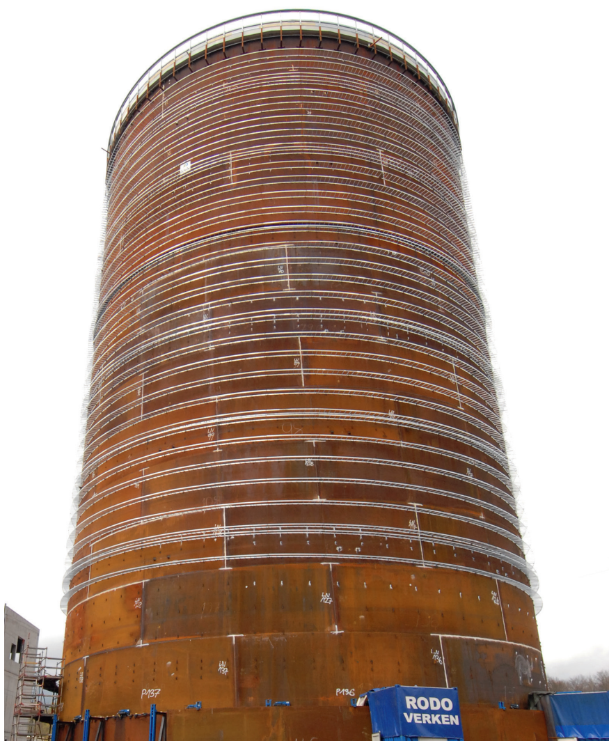
Großes Projekt in Kiel: Der Wärmespeicher der Stadtwerke Kiel hat seit einigen Tagen die endgültige Höhe von 60 Metern erreicht und erhält noch eine Außenfassade aus Trapezblech in Graualuminium. Ab Mitte Juni wird der 60 Meter hohe Speicher dann mit Wasser befüllt.
